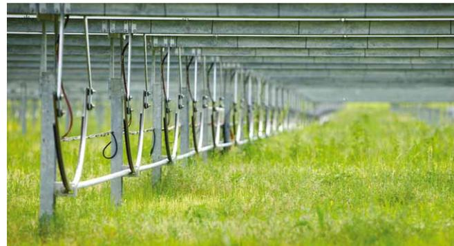
Afin d'optimiser la production d'énergie, les panneaux photovoltaïques suivent la course du soleil : les panneaux sont installés sur des structures mobiles encore appelées « trackers ». La centrale solaire de Porette de Nerone est équipée de trackers solaires à un axe horizontal. Les panneaux suivent ainsi la course du soleil du matin au soir. Le gain de production par rapport à une centrale fixe est de 15 %.
