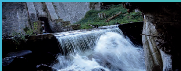
Retenue d'eau de La Cassagne (Pyrénées-Orientales)
